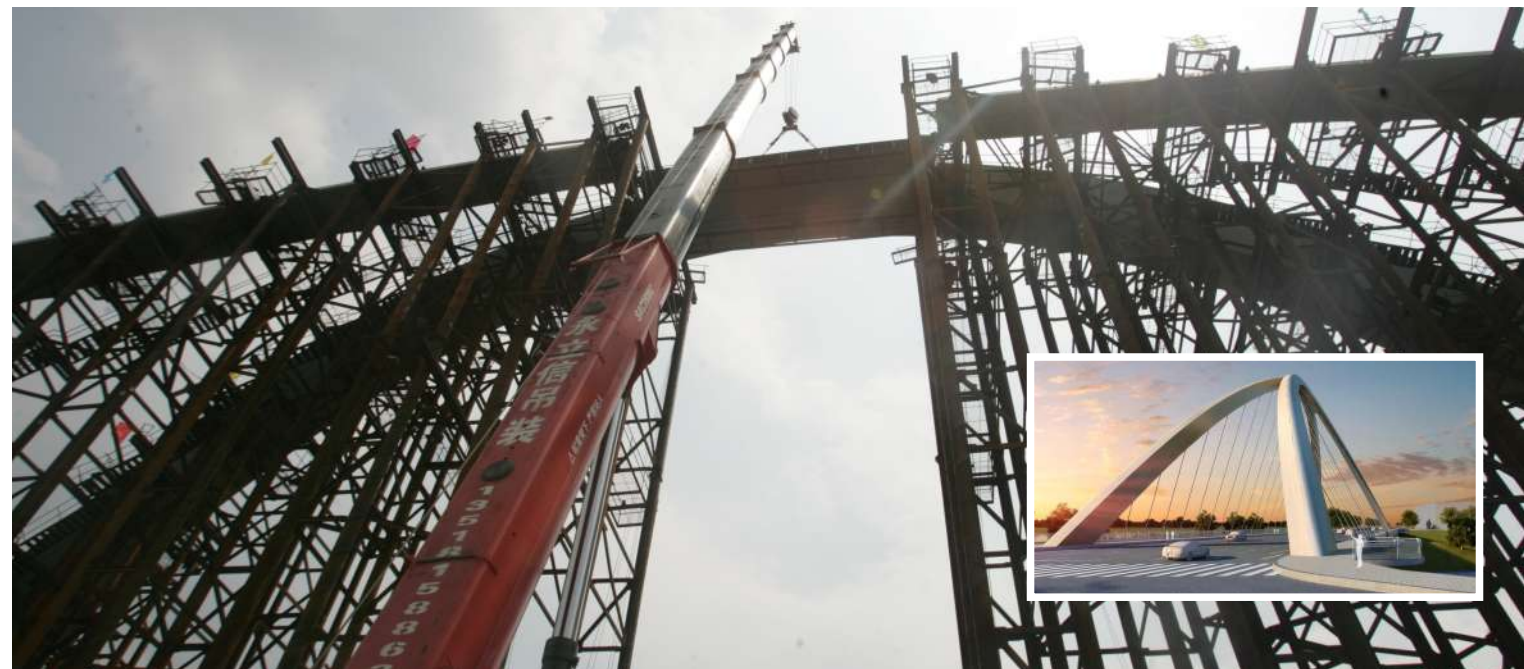
科学城北路西段跨泄洪道大桥顺利合龙（小图为大桥效果图）
